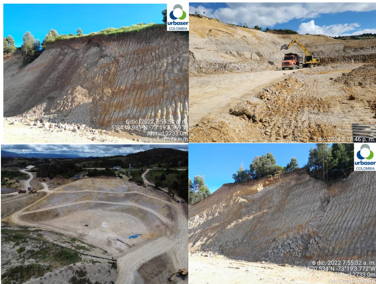
Figura 11-2. Formación Tilatá – excavaciones Fuente: INGEOMAD SAS, 2026.
